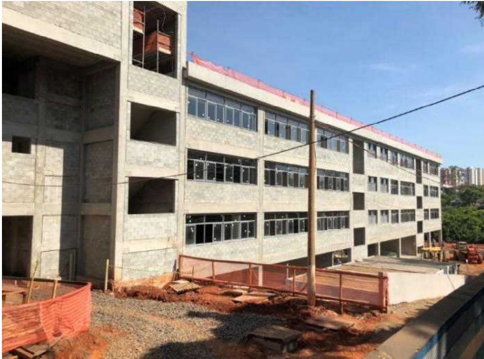
工事中のバウルにある新しいマリアニスト学校：付属建物の一軒
